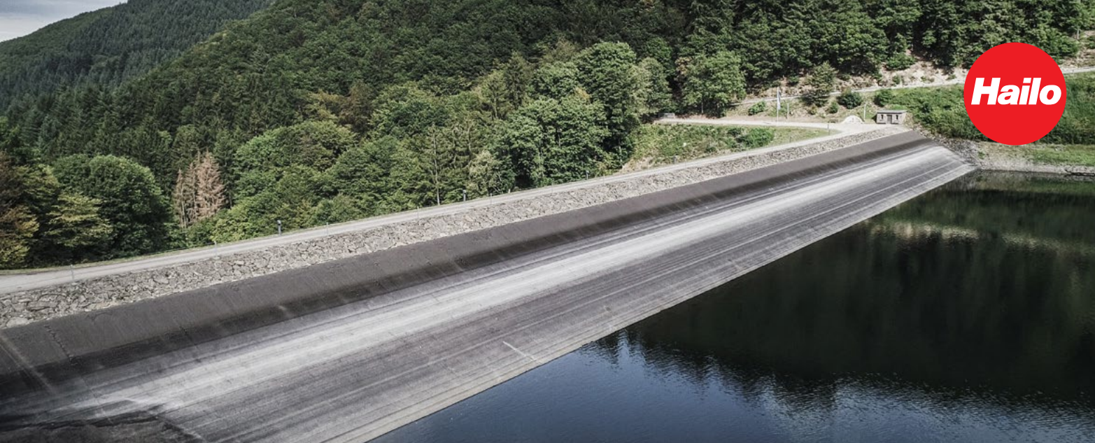
Talsperre (Trier), GLOBALlift im Schieberschacht, 50 m tief
