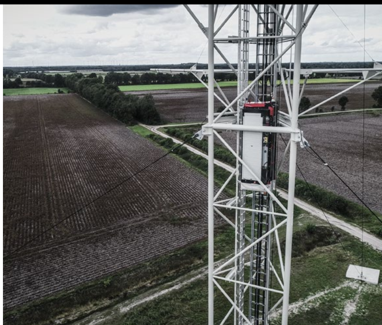
Stahl-Wettermast (Meppen), TOPlift, 80 m Turmhöhe
